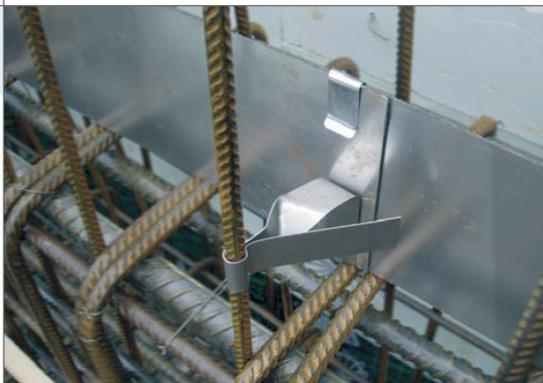
La staffa BiegeFix si infila sulla banda in lamiera con il lato della staffa da sopra e da sotto. È sufficiente ruotare l'estremità girata intorno all'armatura e chiudere premendo con una pinza.
