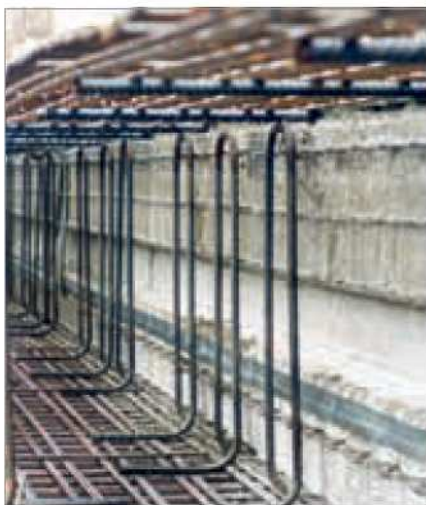
giunto dentato secondo disegno tipo 4010 *strong*
