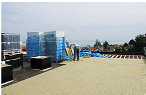
Pannello isolante a due strati per l'uso in tetti piani, calpestabile solo limitatamente per la manutenzione. Disponibile anche come soluzione per tetti con compluvio.
