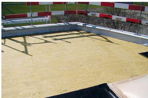
Pannello isolante omogeneo da alte proprietà termoisolanti, per l'uso in tetti piani, calpestabile solo limitatamente per la manutenzione.
