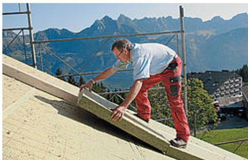
Pannello isolante a due strati con strato inferiore elastico e strato esterno più duro. Isolamento per tetti spioventi sopra i correntini, fra i listelli e per tetti Flums o Eiger. Isolamento per pavimenti dei solai (soffitte) sotto ai pannelli in posa.
