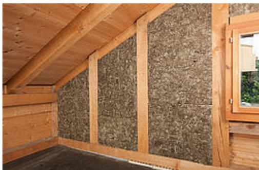
Pannello isolante universale per tamponamento nell'edilizia in legno e per isolamento centrale nell'intercapedine di murature doppie.
