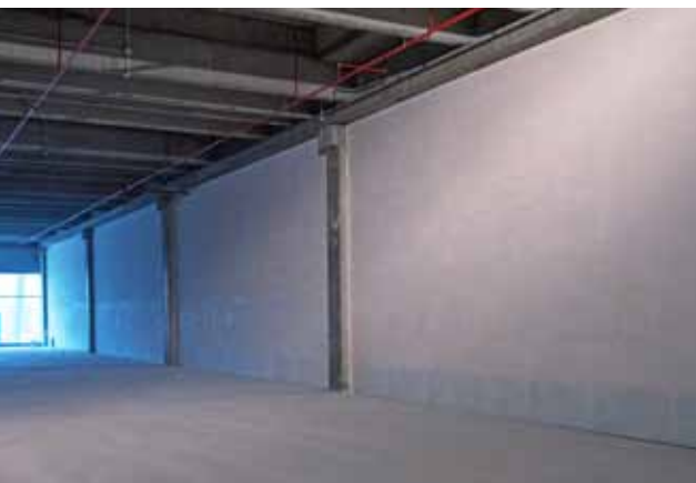
Esempio di pareti VIVO ® X-ALTO realizzate nel centro commerciale ESP di Ravenna, superficie totale di 15.000 mq e altezza 8,50 m, certificate al fuoco con verifiche sismiche.
