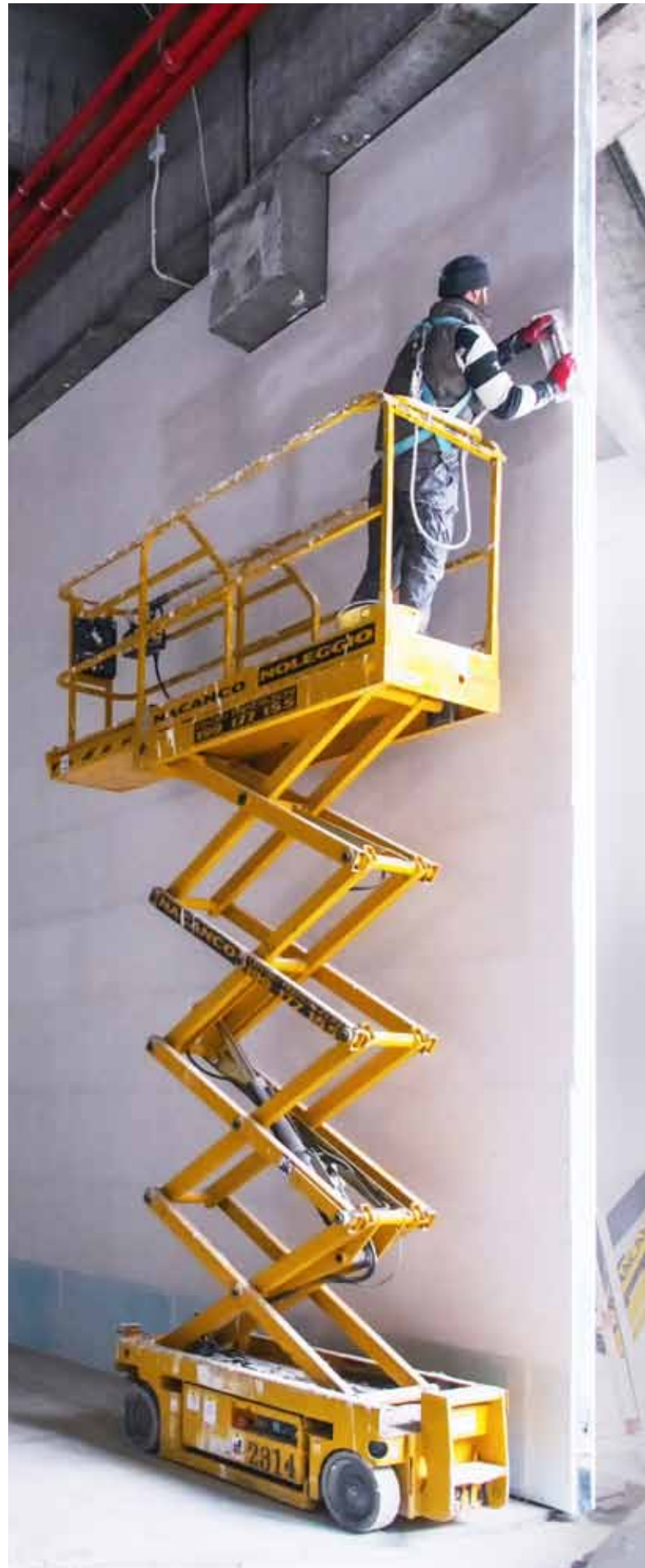
Esempio di pareti VIVO ® X-ALTO realizzate nel centro commerciale ESP di Ravenna, superficie totale di 15.000 mq e altezza 8,50 m, certificate al fuoco con verifiche sismiche.
