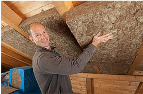
Elastische Dämmplatte in verschiedenen Breiten mit spezieller Knautschzone entlang der Längsseite. Einbau im konstruktiven Holzbau mit Zwischenmassen von 460 bis 700 mm.
