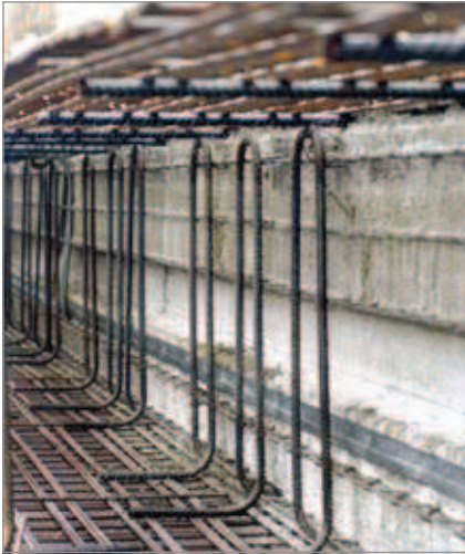
Verzahnungsfuge nach Plan Typ 4010 *strong*
